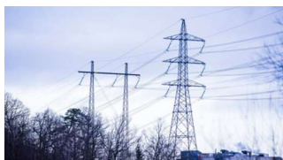
Ingelkärr Ny luftledning i Lerum och Ale Kommun.
