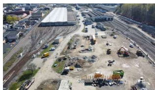
Högdalsdepån Utbyggnad av tunnelbanedepå, Stockholm.
